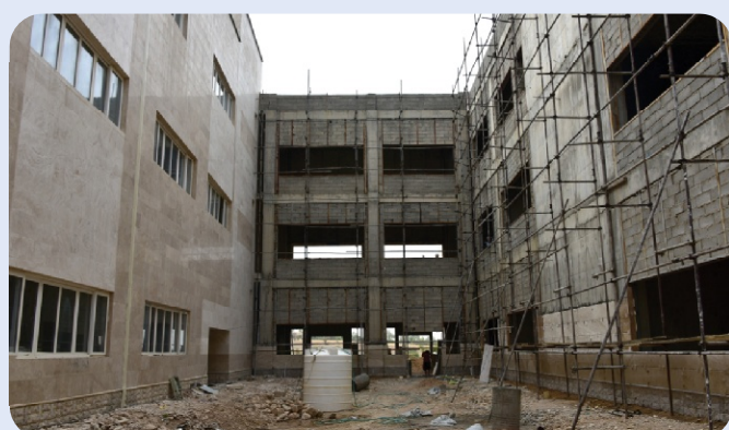
تداوم اجرای عملیات نمای ساختمان مجموعه کلاس/ها / تابستان 1401
