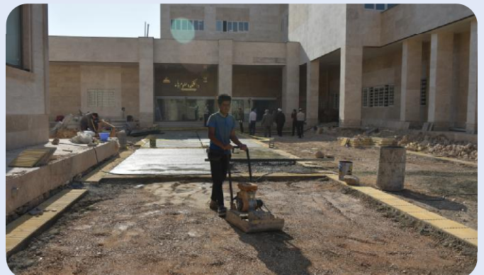
زیرسازی محوطه‌سازی در ورودی ساختمان دانشکده علوم پایه و سلف سرویس پردیس مهر و آبان 1401
