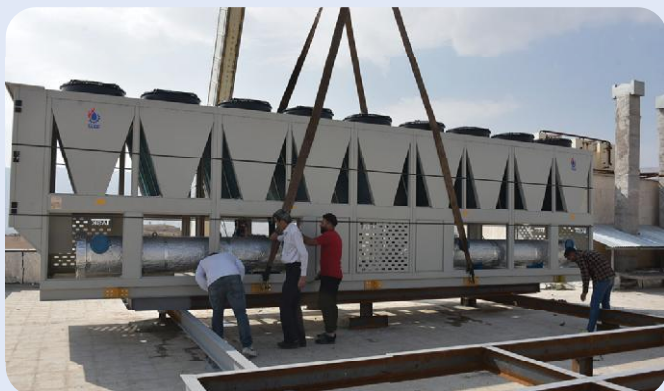
نصب چیلر در ساختمان دانشکده علوم پایه پردیس دانشگاه 16 آبان 1401
