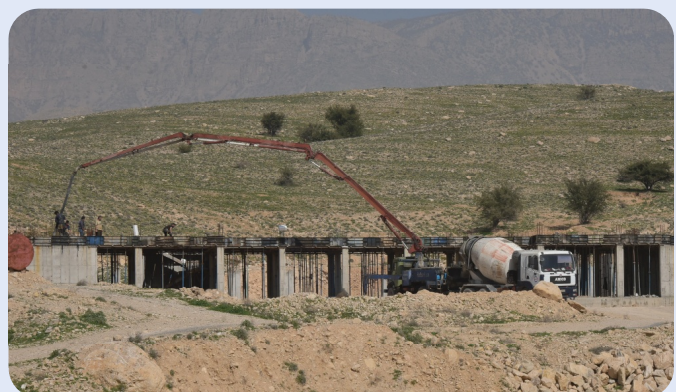
تداوم عملیات احداث خوابگاه خیر ساز - بهمن 1401
